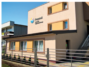
Ośrodek Wypoczynkowy Przystań w Grzybowie k. Kołobrzegu
